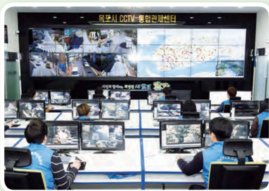
목포시 CCTV 통합관제센터 운영
