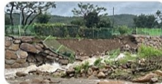
하천 제방 유실
